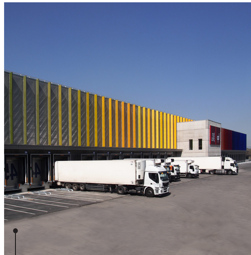
GRUP BON PREU Centre logístic Balenyà, Barcelona Superfície construïda: 78.000 m 2
