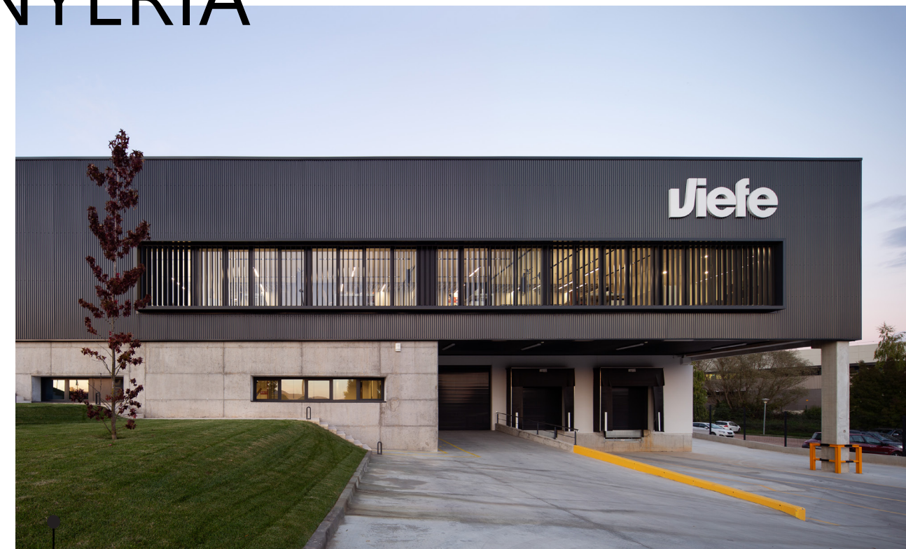
VIEFE Nau industrial i oficines St. Pere de Torelló, Barcelona Superfície construïda: 3.186 m 2
