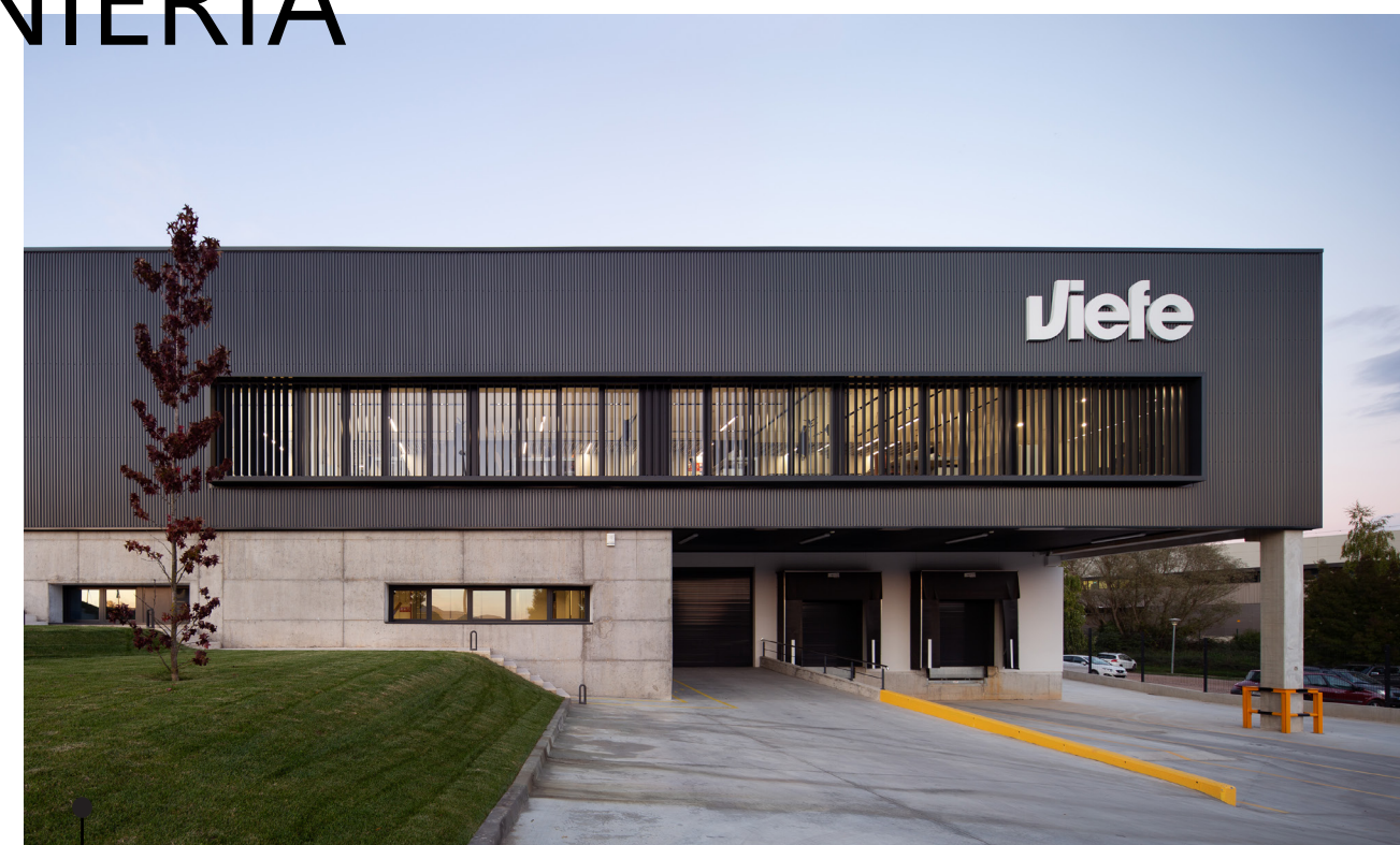
VIEFE Nave industrial y oficinas St. Pere de Torelló, Barcelona Superficie construida: 3.186 m 2
