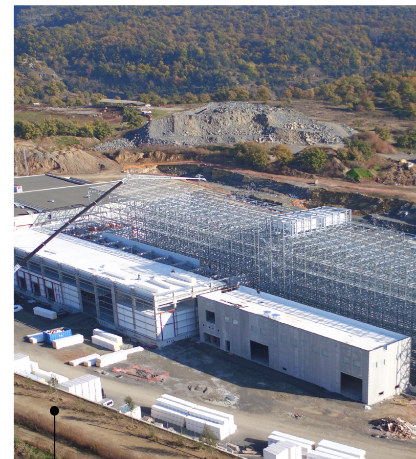
GRUPO VALLCOMPANYS - PATEL Almacén robotizado a -20 °C y muelles de expedición refrigerados L'Esquirol, Barcelona Superficie construida: 22.100 m 2
